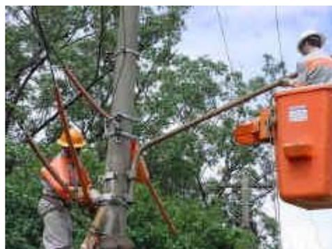
Figura 2 – Posicionamento, alinhamento e fixação do suporte tipo braço no poste com cesta aérea
